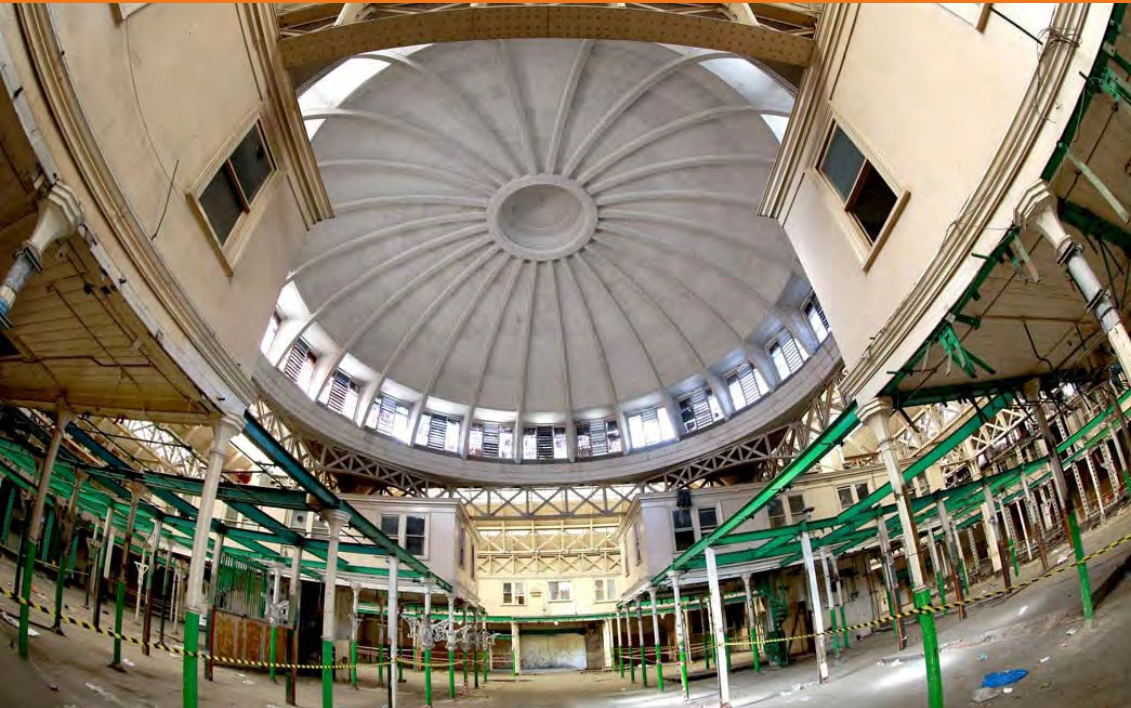
1953 年，原本覆盖通用市场中央通高大厅的木制塔状屋顶被替换为了四周环绕高窗的混凝土穹顶，从而为通用市场提供一个更坚固且采光通风性能更好的屋顶。(图片来源/ 伦敦市博物馆)
